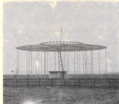
Afb. 30. Het doppler VOR-baken „RTM“ te Berkel-Rodenrijs dat o.a. wordt gebruikt in het vertrek- en naderingsgebied van de luchthaven Rotterdam. In het midden de DME-antenne.
